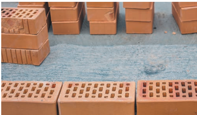
Рис. 7. Гидроизоляционная отсечка
