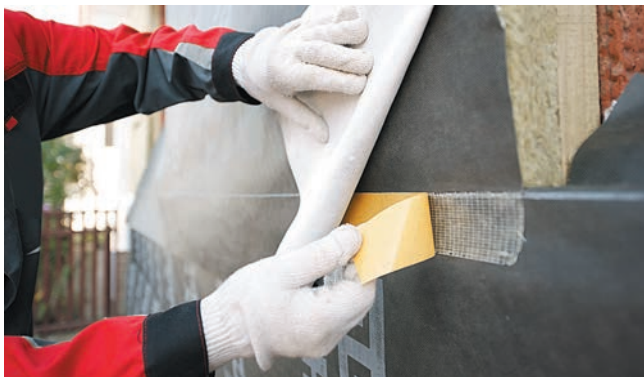
Рис. 5. Монтаж и проклейка стыков полотен ветро-, влагозащитной мембраны
