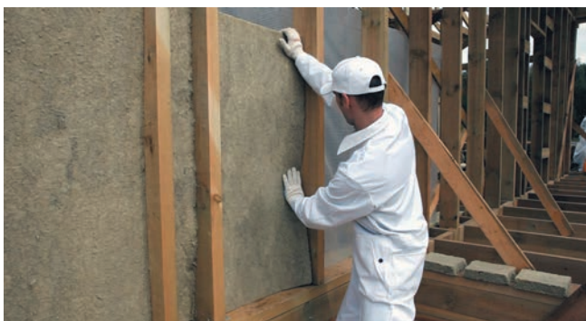
Рис. 20. Монтаж теплоизоляционных плит
