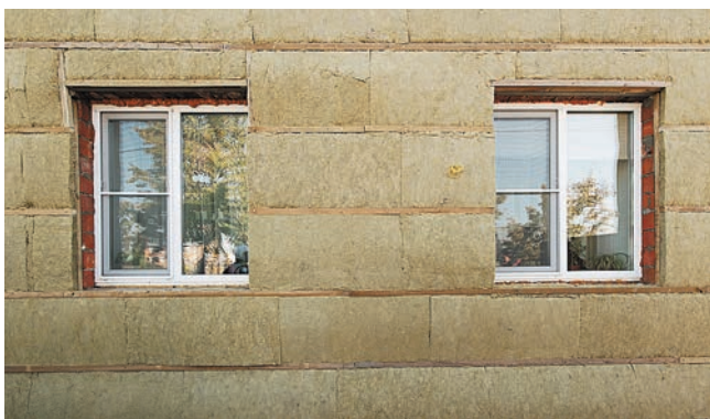
Рис. 4. Монтаж теплоизоляционных плит в горизонтальный каркас
