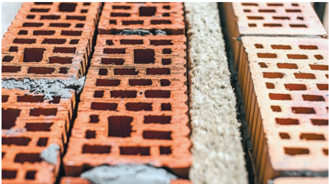
Рис. 11. Монтаж плит теплоизоляции
