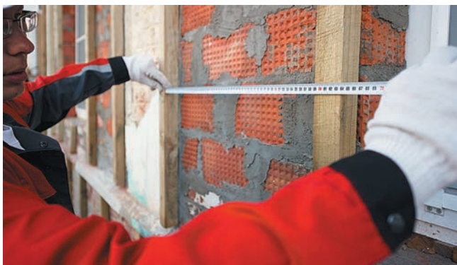
Рис. 1. Крепление вертикальных стоек деревянного каркаса
