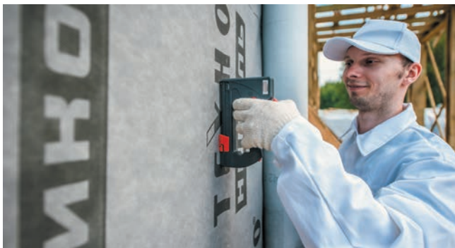
Рис. 21. Монтаж ветро-, влагозащитной мембраны
