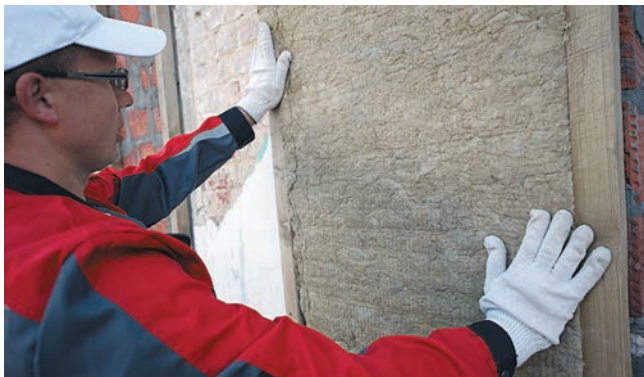
Рис. 2. Монтаж теплоизоляционных плит в вертикальный каркас
