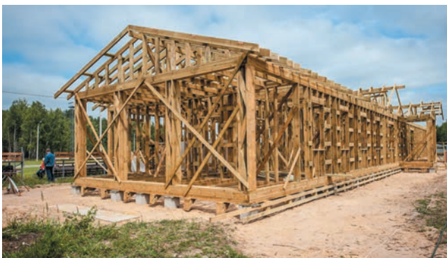
Рис. 18. Установка деревянного каркаса
