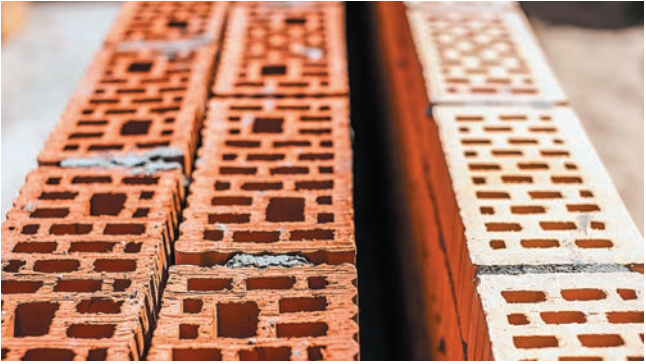
Рис. 10. Монтаж внутренней версты
