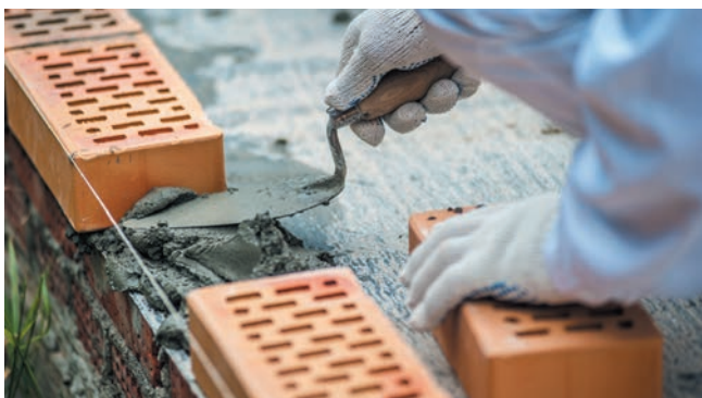
Рис. 9. Монтаж внешней версты
