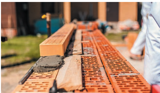
Рис. 14. Монтаж внешней версты после установки гибких связей
