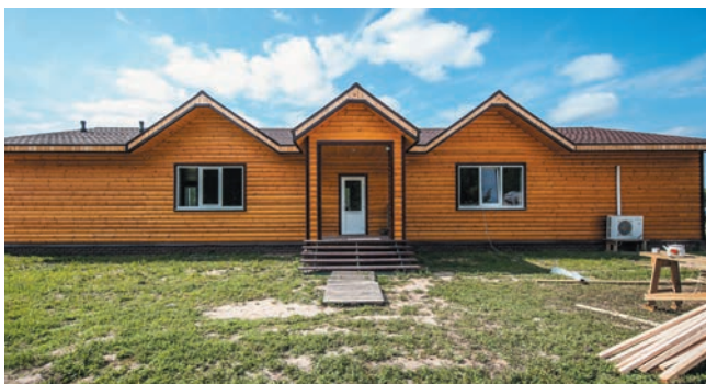
Рис. 22. Монтаж облицовочного материала
