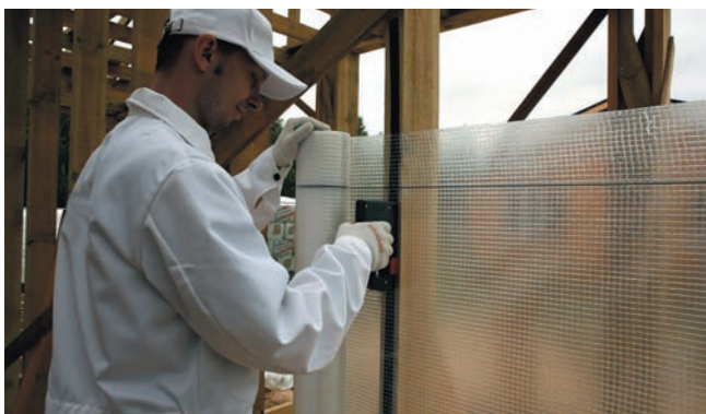
Рис. 19. Монтаж пароизоляционной пленки
