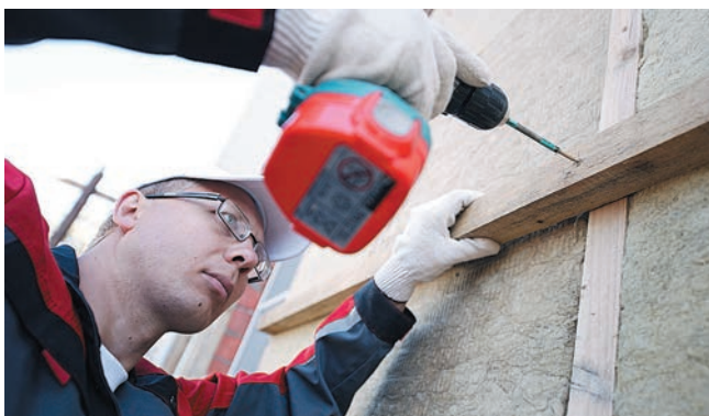
Рис. 3. Установка горизонтального каркаса
