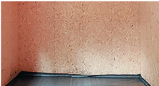
Рис. 23. Обшивка внутренней поверхности стен
