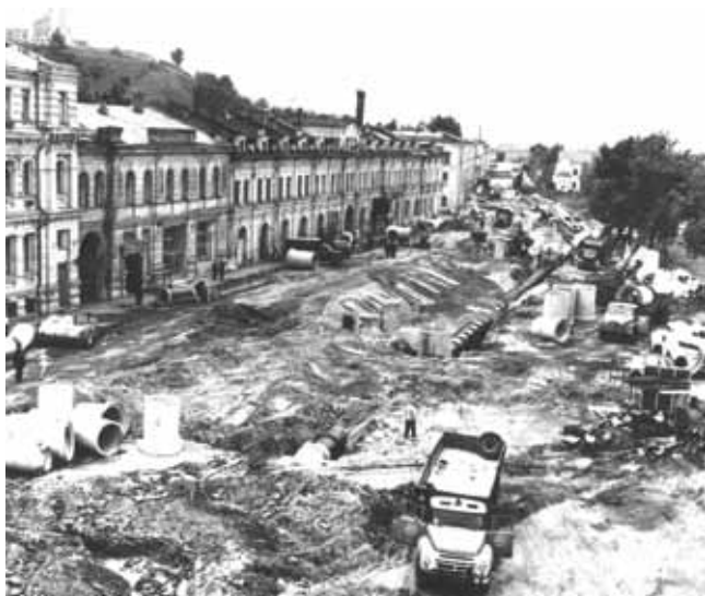
Рис. 1 Прокладка центральной ливневой канализации
