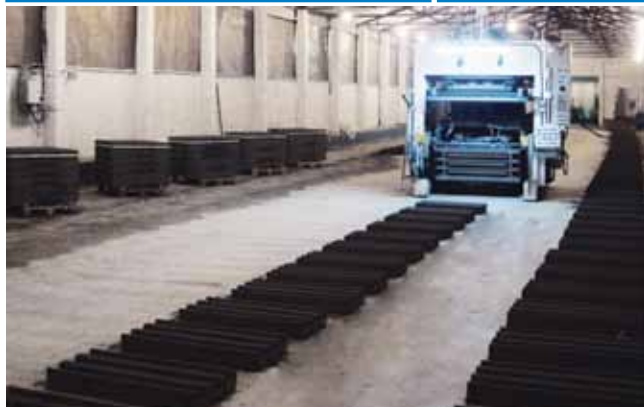
Производство бетонных лотков
